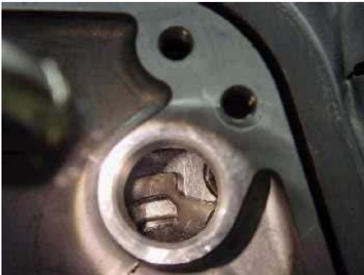
Photo 2 : Côté sortie OK
